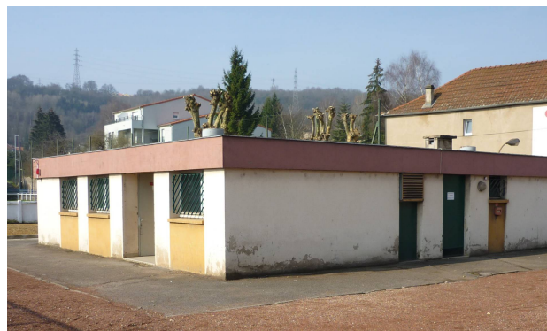
Vestiaire avant travaux
